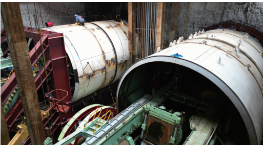
シールドマシン組立の様子
