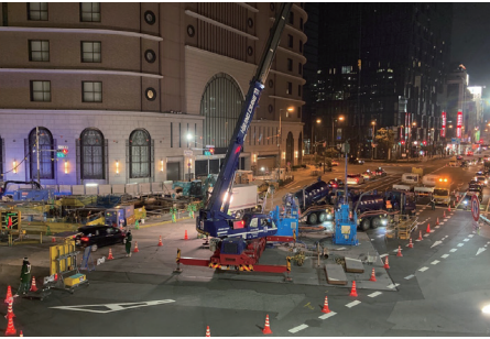
夜間道路規制のなかでの施工状況
