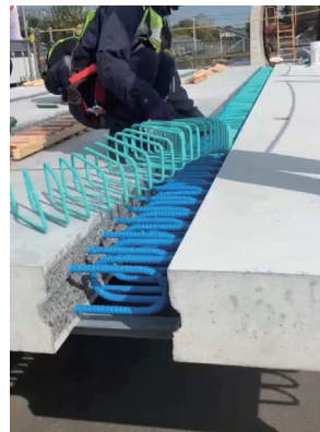
施工性確認試験の実施状況
