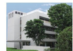
技術研究所管理棟
