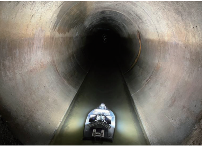
下水道管路内の調査作業
