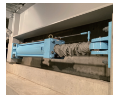
VOD®の設置状況
