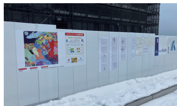
庁舎建設現場(青森県)
