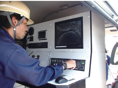
カメラ調査モニター確認
