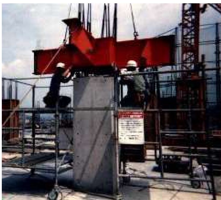
柱梁接合部鉄骨の取り付け状況
