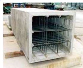
エコカラムと柱・梁主筋の組立て状況
