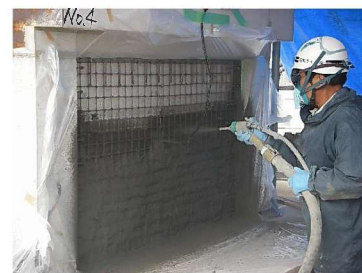
モルタル吹付け状況
