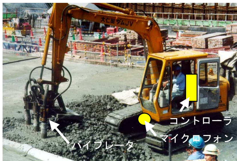
ダムコンクリート締固め状況
