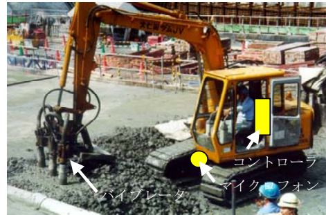
コンクリート締固め状況
