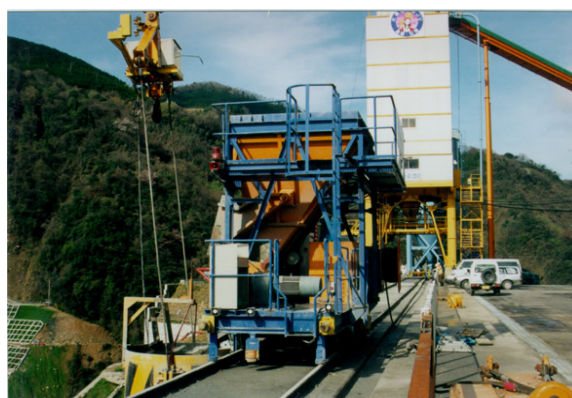
トランスファーカ・バッチャープラント(大長見ダム)
