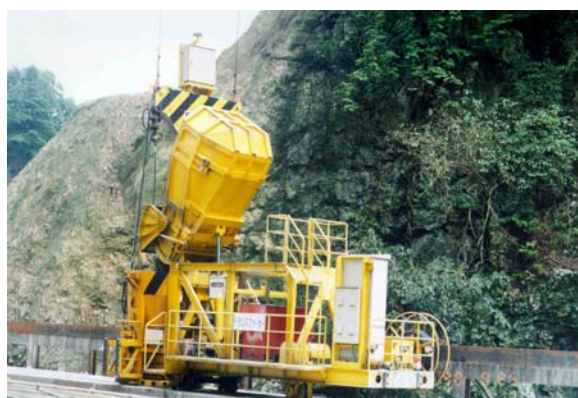
トランスファーカ(大仁田ダム)
