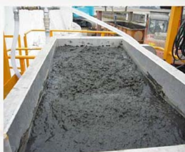
▲脱水処理対象泥土
