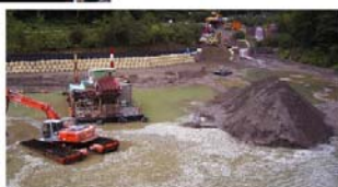
泥土掘削機による浚渫作業▶
