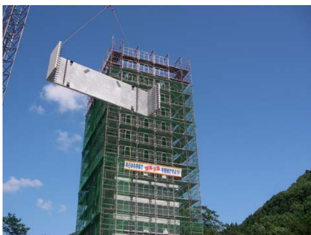
3Hパネルの吊りこみ
