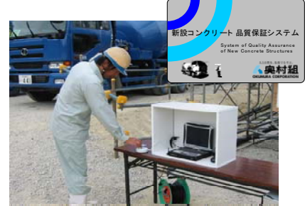
ICカードによるコンクリートの受入
