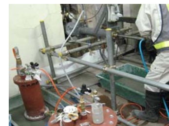
背面水圧コア削孔状況
