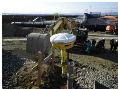
写真-1 GNSS(GPS)基地局 (※丁張は施工精度確認用に設置したもの)
