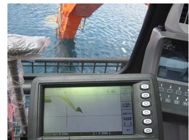
写真-5 浚渫工事への適用事例
