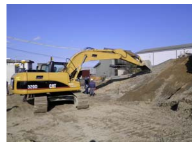
写真-4 マシンガイダンスによる法面整形状況
