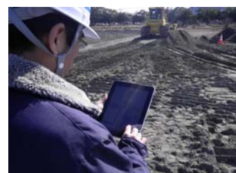
写真-3 iPad による施工管理
