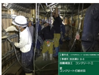
施工当初の打設状況 (多人数)
