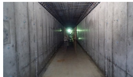
仕上がり状況
