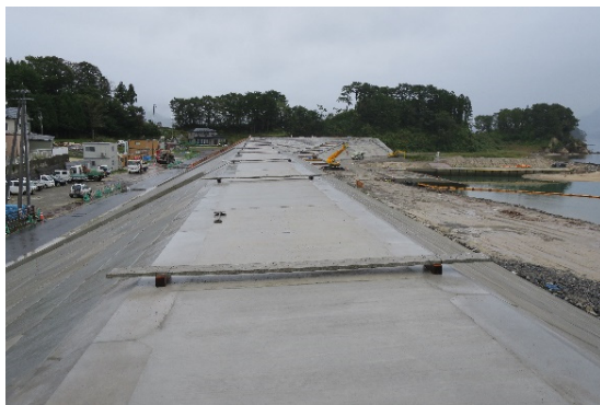
山田町織笠における防潮堤頂部 間詰めコンクリートへの適用
