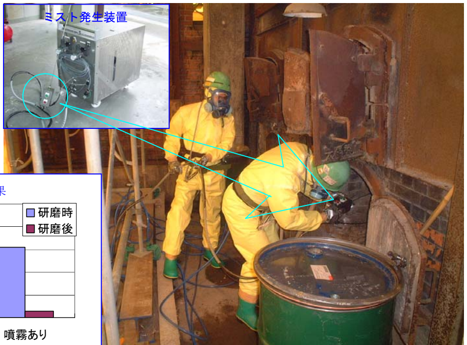
戻出し作業時でのミスト散布状況
