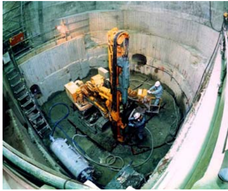
スロットスターによるスロット削孔状況 (日経コンストラクションより 撮影:玉井強志)
