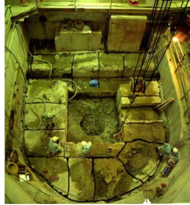
ブロック分割したコンクリートをクレーンで搬出
