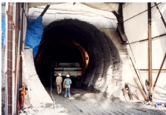
堤体内導水路の施工状況
