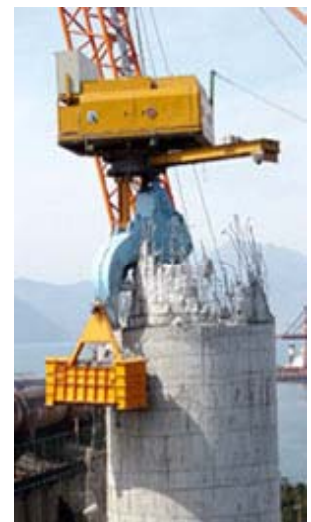
写真-4 NOCC 機による煙突解体
