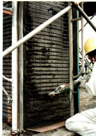
モルタルの吹付け
