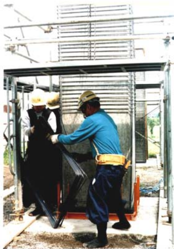
スパイラル鉄筋の装着
