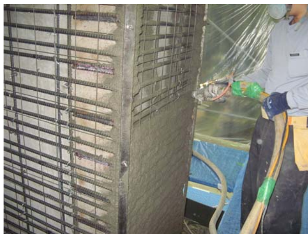
吹付けコンクリート施工
