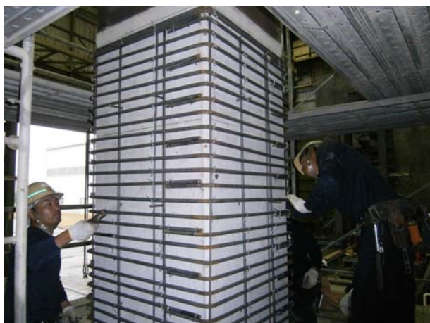
せん断補強鉄筋巻立て
