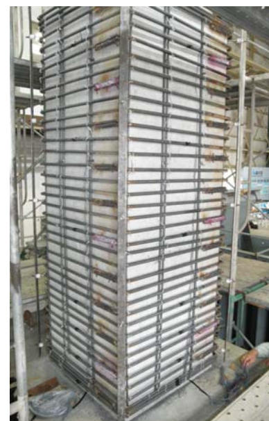
補強鉄筋巻立て完成状況
