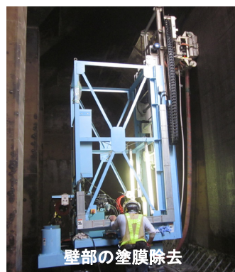
壁・柱用 WJ マシンの施工状況
