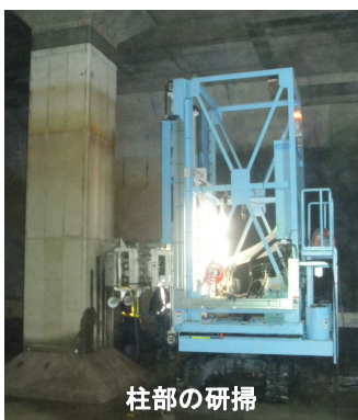
壁・柱用 WJ マシンの施工状況
