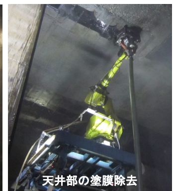
天井用 WJ マシンの施工状況
