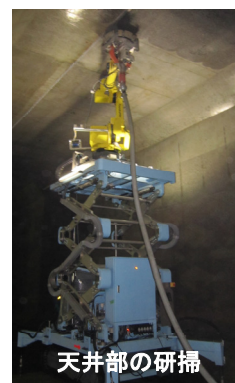
天井用 WJ マシンの施工状況
