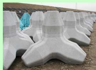
写真-4 根固めブロック
