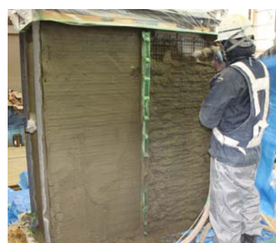
③モルタル吹付け
