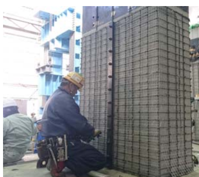
②せん断補強鉄筋の組立
