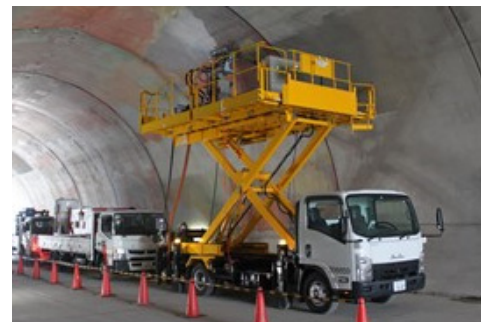
写真-4 施工状況全景
