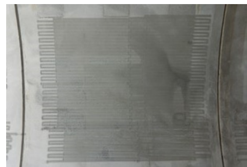
写真-5 処理面の出来形
