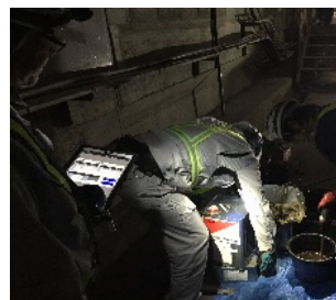
作業時入力(止水工)
