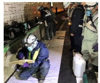
作業時入力(断面修復工)
