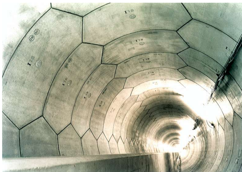
ハニカムセグメントによる下水道トンネルの覆工状況
