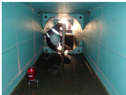
レーザー墨出し器(水平・垂直)を用いたルーフ打設精度管理
