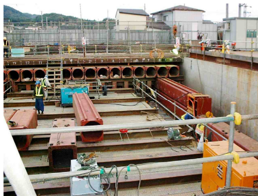
鉛直部2列同時施工
