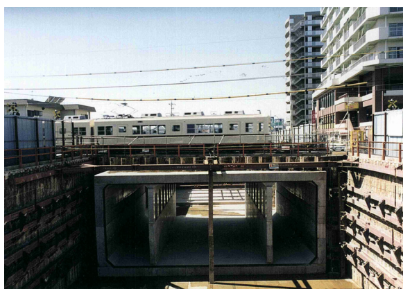
土被り浅く設置された函体
