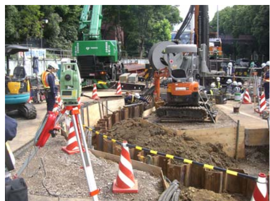
打設位置管理状況
