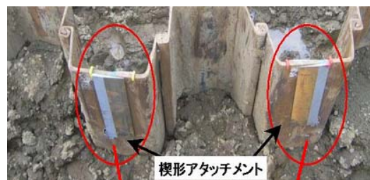
角度補正プレート取付状況
