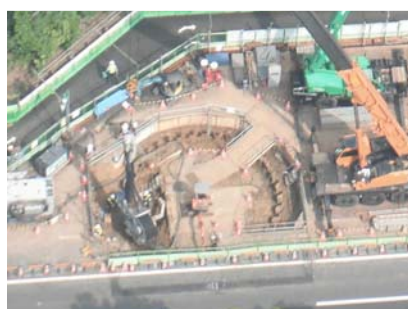
鋼矢板打設状況(上空写真)
