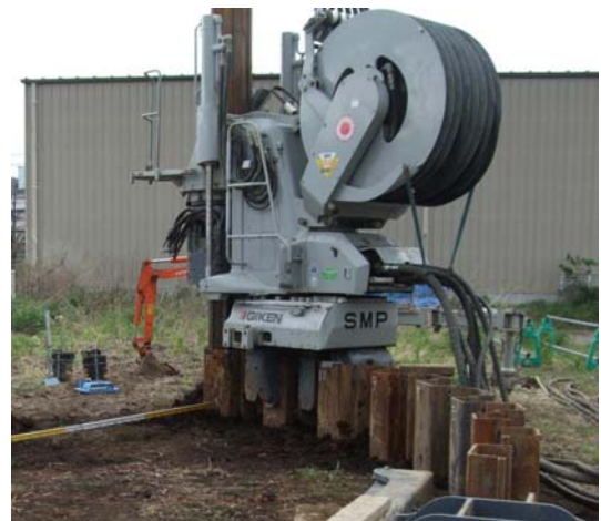
鋼矢板の円形打設状況
