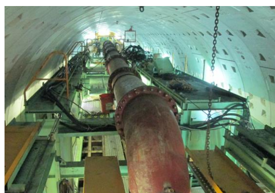
写真-2 噴発防止用鋼管（φ600 mm、L=30m）
