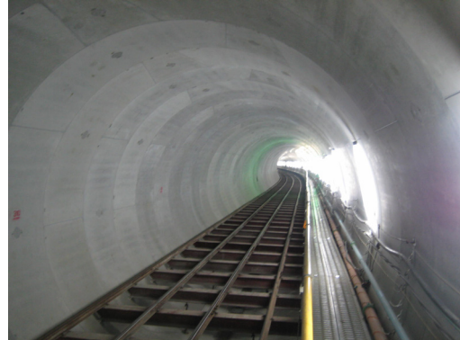
写真-3 一次覆工の仕上がり
