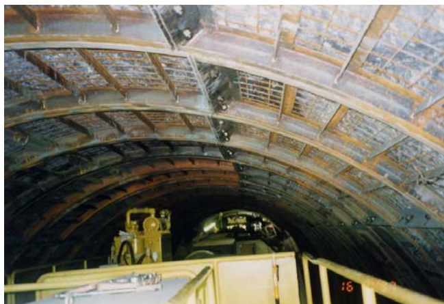
ロックライナーを支保として掘進中のTBM
