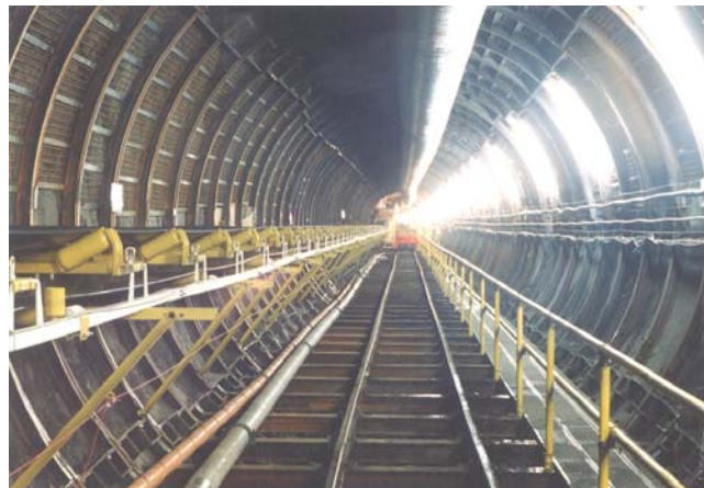
ロックライナー工法で施工したD種区間
