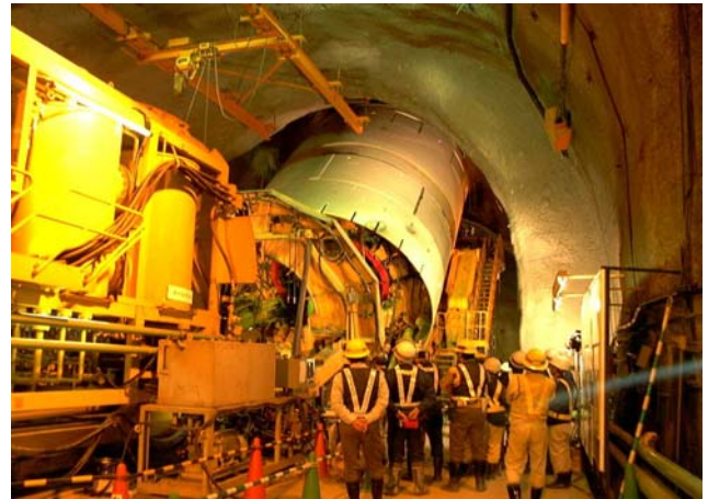
全断面斜坑TBM 発進状況
