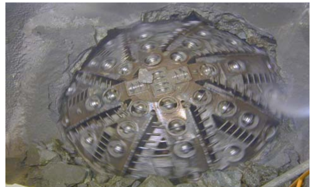
全断面斜坑TBM 到達状況
