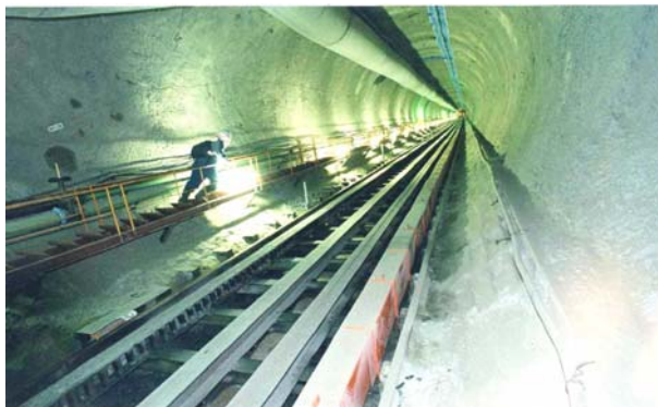
水圧管路斜坑(勾配 48 度) 坑内状況
