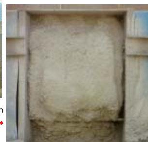
↑ 吹付け速度 12m³/h 吹付け厚 40cm →
