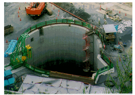
写真-2 奥津第二発電所立坑
