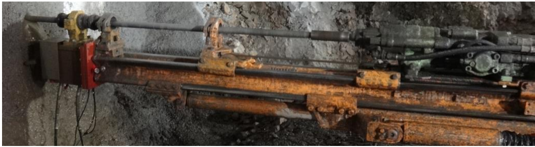
写真-3 ガイドセル先端固定装置付きの油圧削岩機による穿孔状況
