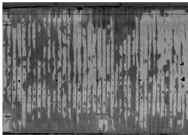
図-3 反射強度による支保工、ロックボルトの位置確認
