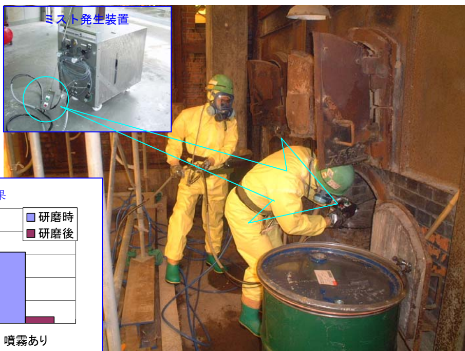
灰出し作業時でのミスト散布状況
