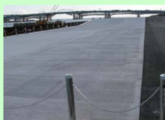
写真-3 舗装コンクリート
