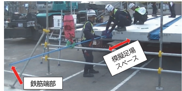
写真－4 ループ継手工法の鉄筋挿入状況
