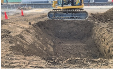
写真-3 自動掘削による出来形 (ケース 1)
