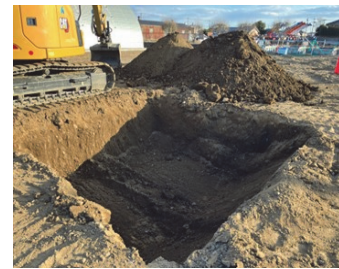
写真-5 自動掘削による出来形 (ケース 3)
