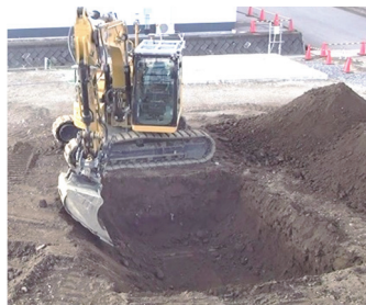
写真-2 チルトローテータを使用した斜面掘削状況
