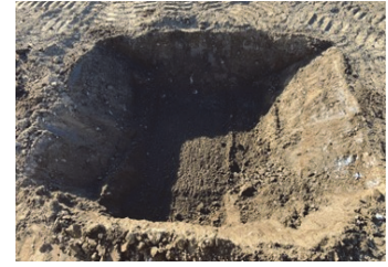
写真-4 自動掘削による出来形 (ケース 2)
